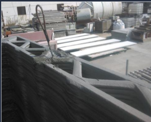
大型建筑3D打印机 长150米，宽10米，高6.6
