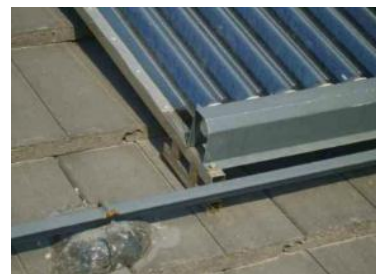
上端预埋件构造
