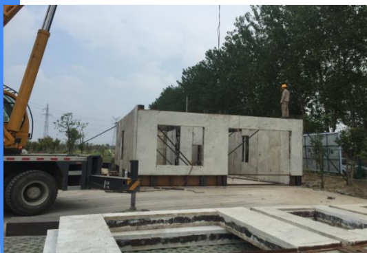
预制墙板吊装作业吊点
