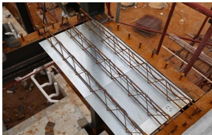
底膜可拆卸钢筋桁架楼承板
