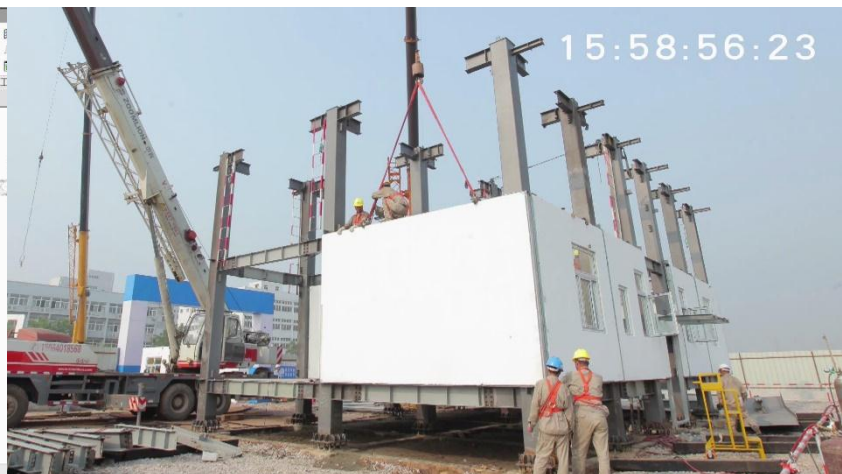
集成装配式墙板安装
