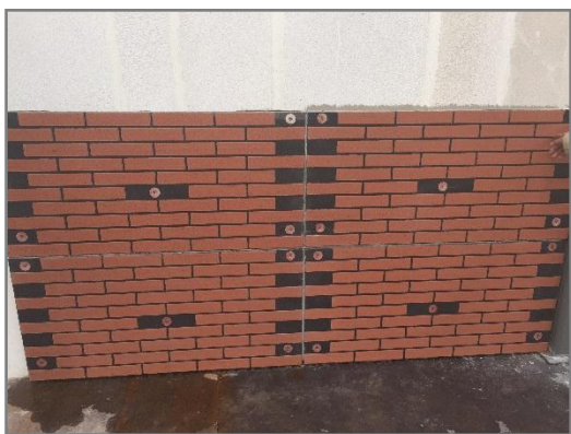
接缝处打胶（硅酮密封胶）
