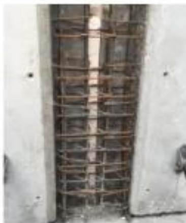
预制构件与现浇连接部位的纵向钢筋
