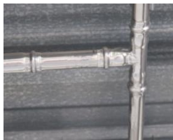
卡压式零泄漏接头
