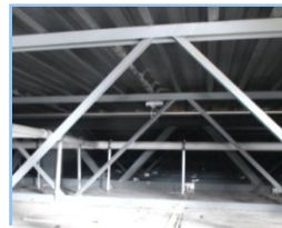
主板中空450mm、750mm，并设维修孔，检修方便
