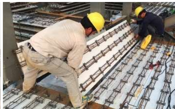
可拆卸式 钢筋桁架楼承板
