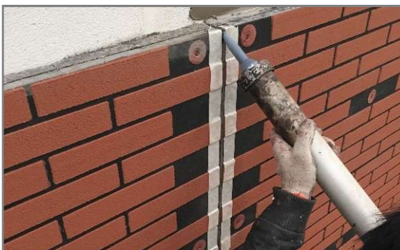
接缝处打胶（硅酮密封胶）
