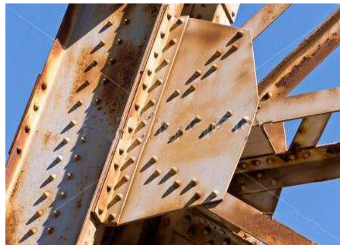
结构腐蚀
