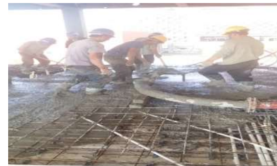
浇筑混凝土
