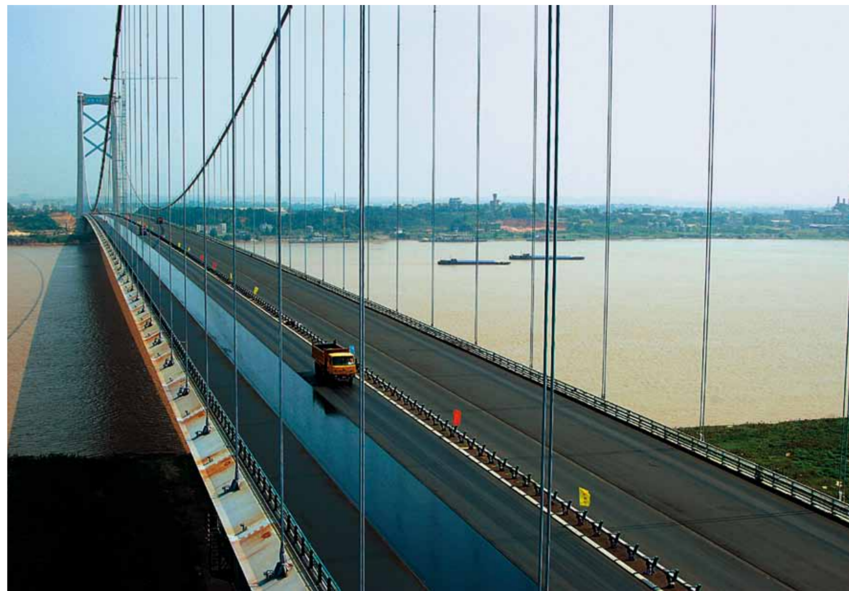
摊铺双层环氧沥青的主桥钢桥面
