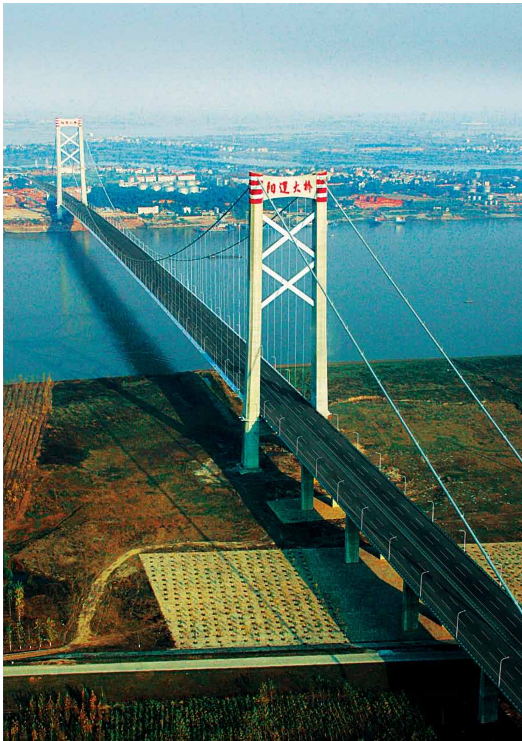
武汉阳逻长江公路大桥白天航拍图
