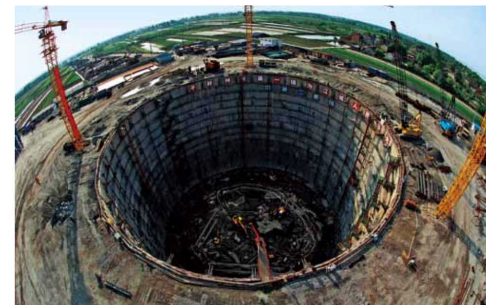
“神州第一锚”阳逻长江大桥南锚碇超大超深圆形基坑
