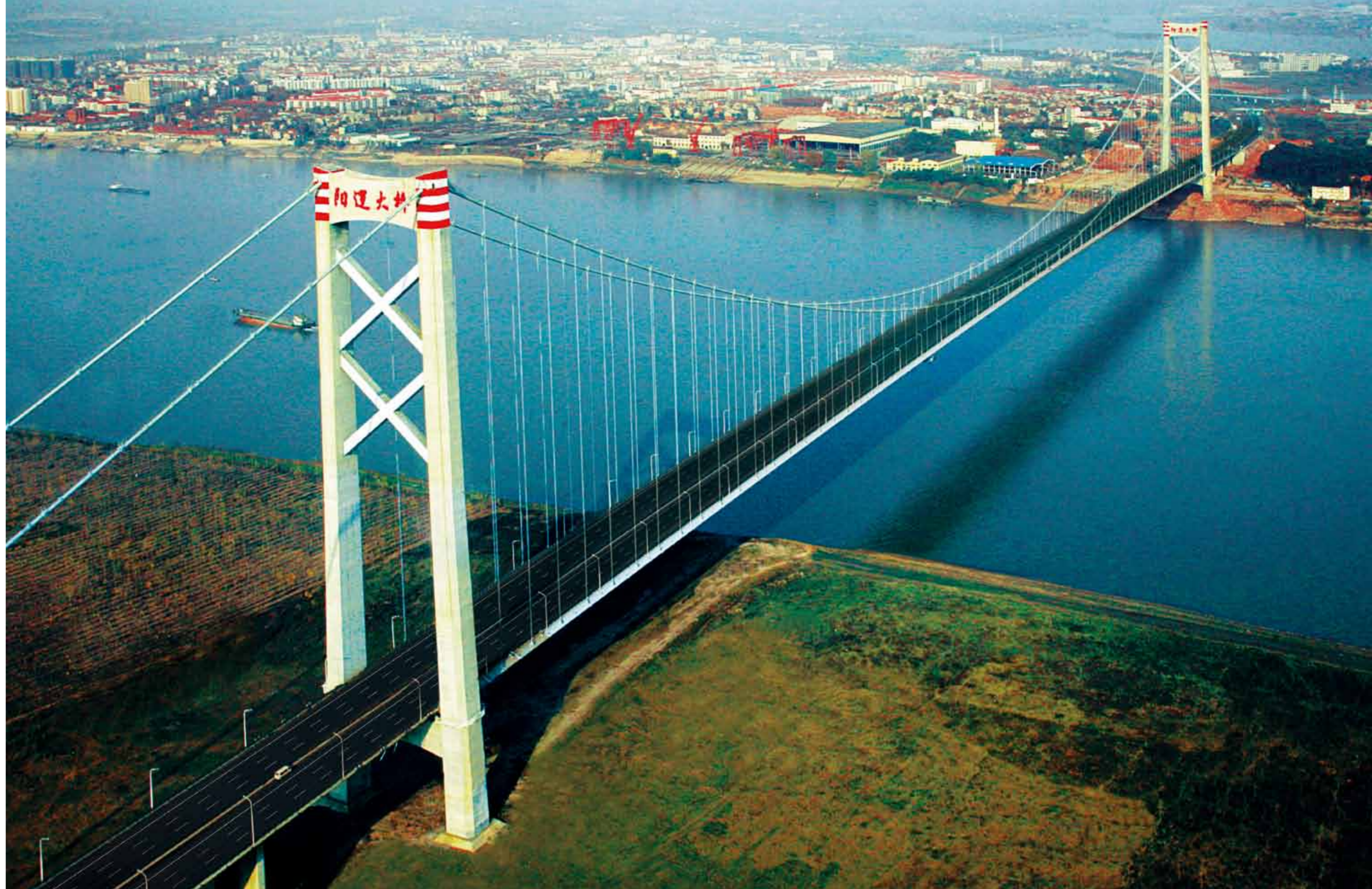
武汉阳逻长江公路大桥白天航拍图
