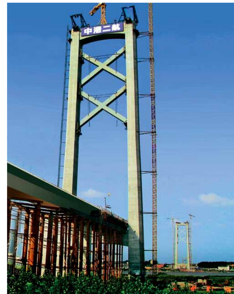
国内特大悬索桥混凝土主塔首次采用钢剪刀撑形式
