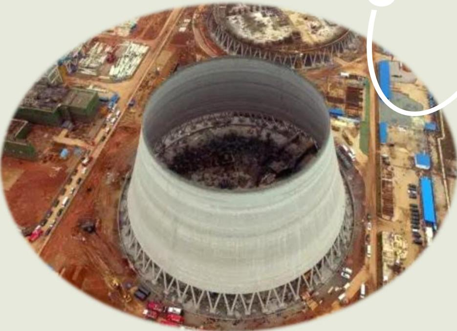
**案例：**震惊国内的11·24江西丰城发电厂三期扩建工程冷却塔施工平台坍塌特别重大事故，国务院事故调查组在工程总承包单位的责任认定中就指出：工程总承包单位存在管理意识薄弱、管理机制不健全、管理制度流于形式、管理人员无证上岗等管理体系建设的问题。
