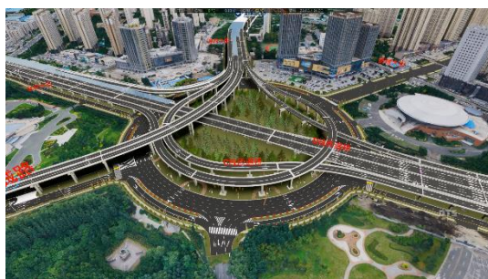
(b) 世纪大街快速路工程
