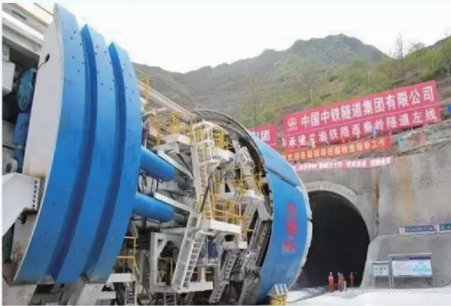
d) TBM掘进现场
