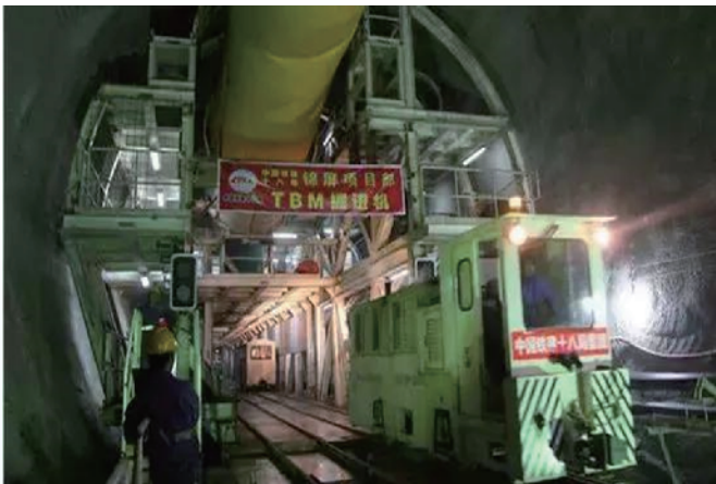
b) 西秦岭隧道TBM总装图
