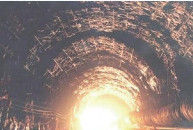
a) 全断面光面爆破效果图
