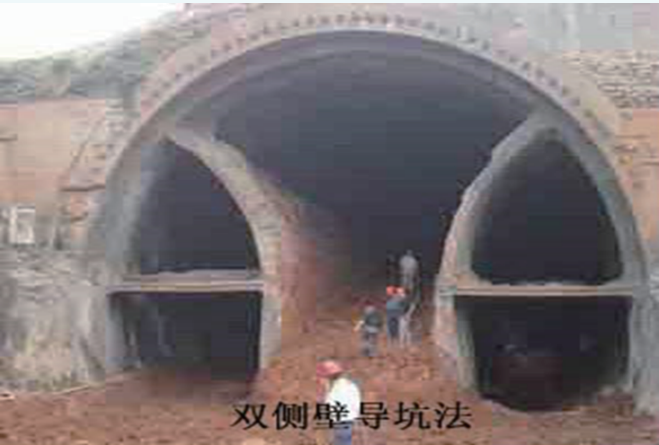
c) 双侧壁导坑法施工图
