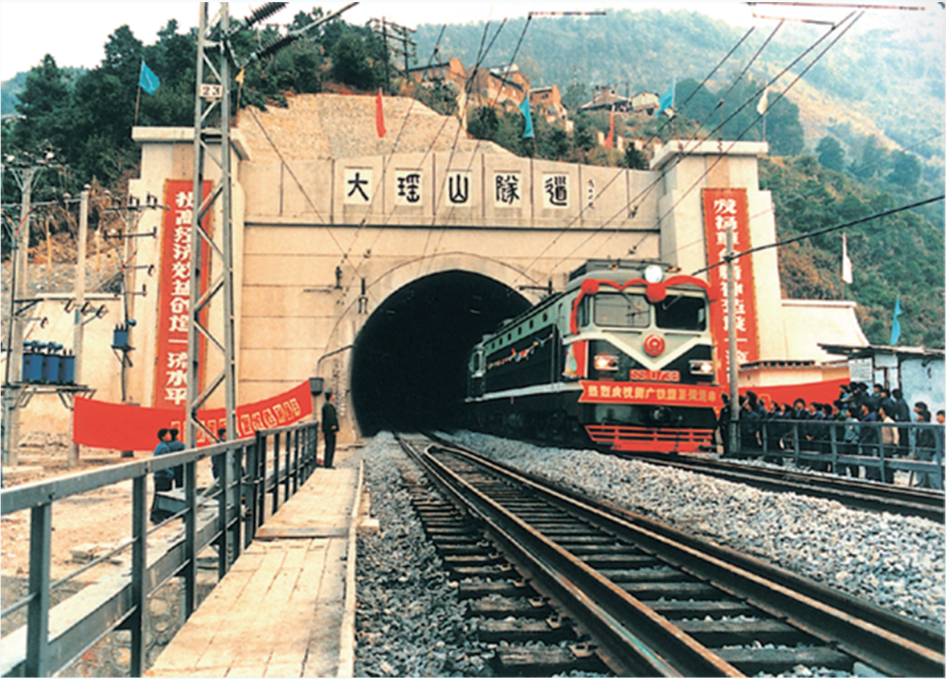
图2-6建成后的衡广复线大瑶山隧道
