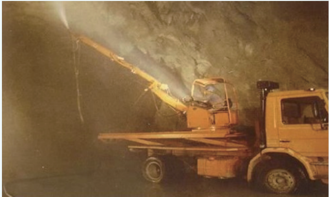
图2-8机械手喷射混凝土
