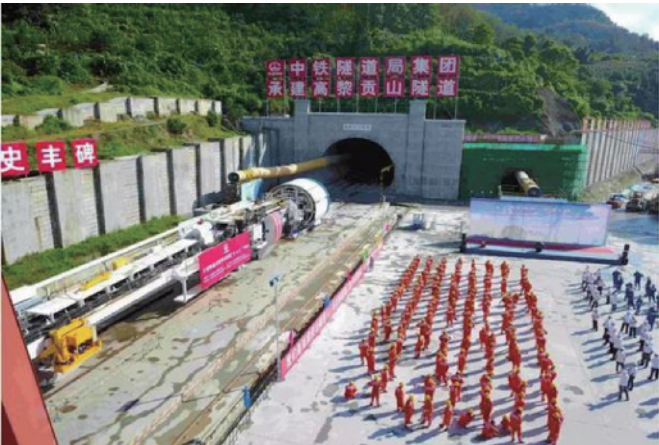
a) 秦岭隧道TBM总装图
