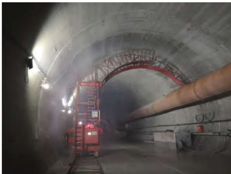
图 2.7 自动喷雾养护台车现场应用图
