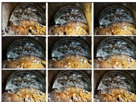
图 2.3-2 虚拟多目系统数字影像采集与掌子面三维重构
