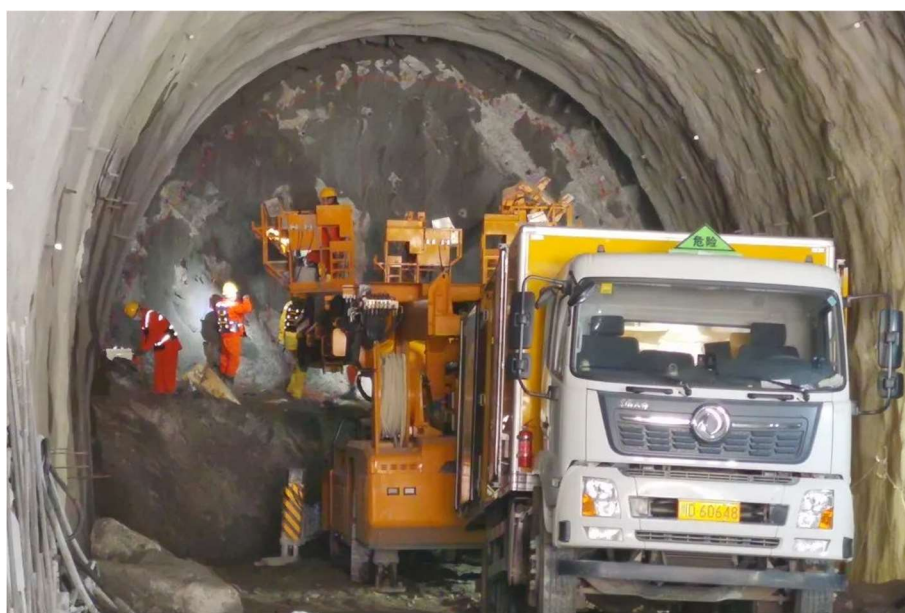
图 2.4-2 隧道智能装药机器人
